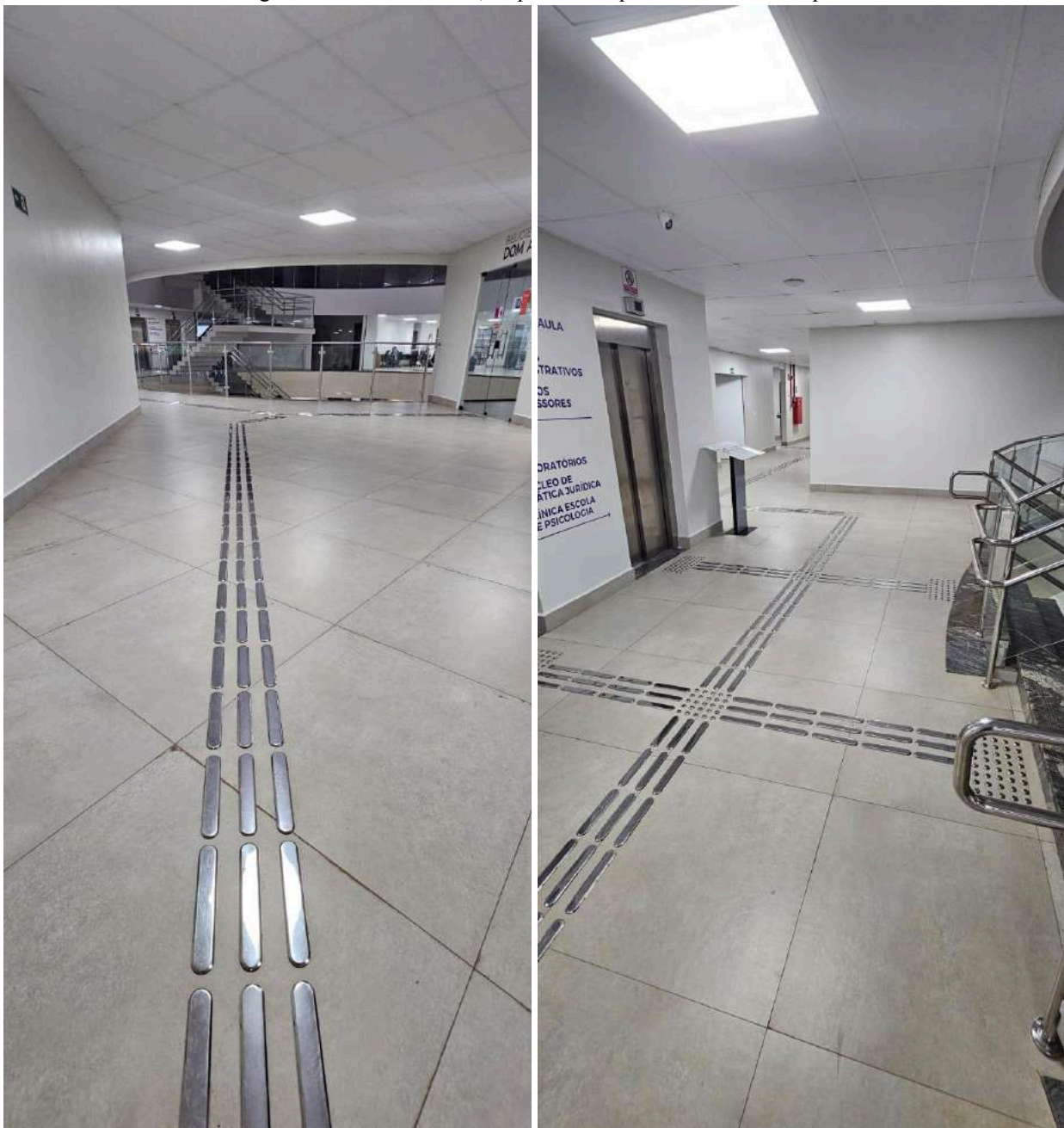
Imagem - Piso tátil em inox, disponível na parte interna do Campus
