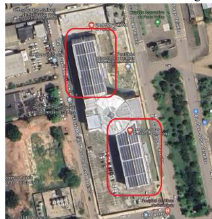
Imagem - Usina Fotovoltaica do novo campus da FCR com geração para toda a demanda institucional colhida no google maps.
